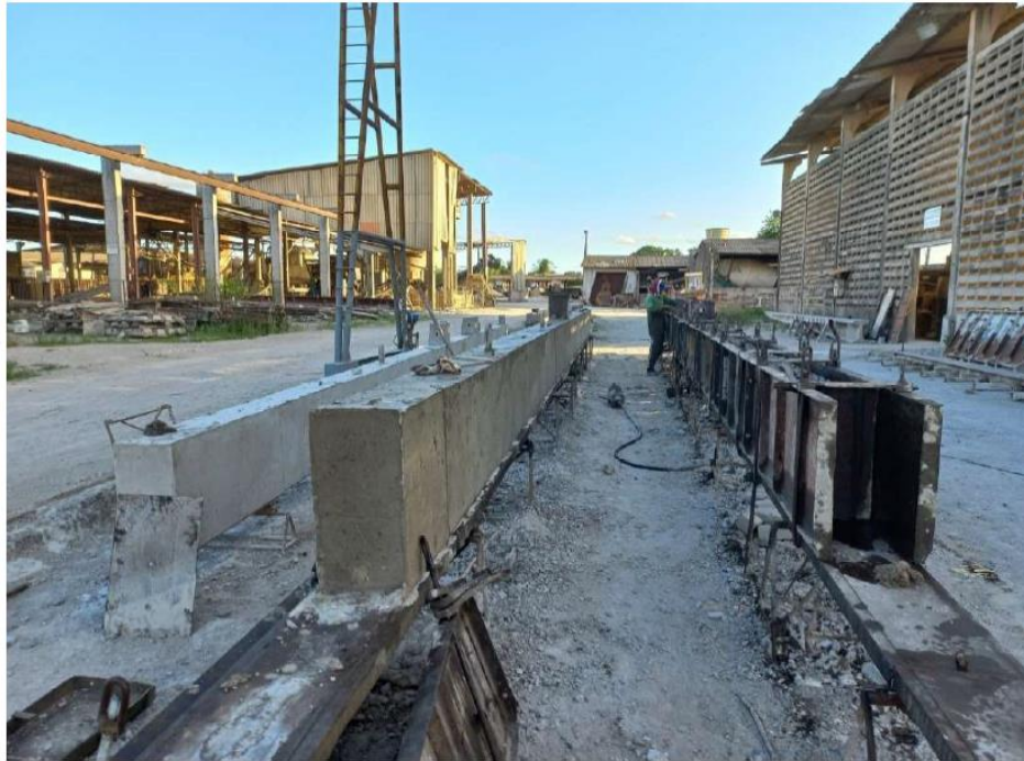
Postes em fabricação.
