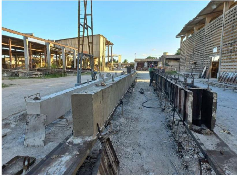
Postes em fabricação.
